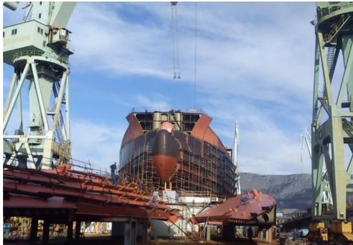
Slika 2. Sekcije potpalubnih bočnih tankova u pripremi za montažu
